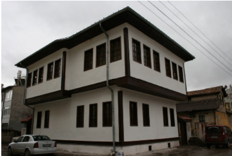
Sivas Yatırım Destek Ofisi Geçici Hizmet Binası - Dr. Ahmet Kemal KÖKSAL Vakfı Konağı, Sivas
