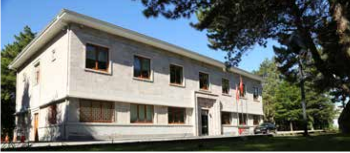
Fotoğraf 1. Orta Anadolu Kalkınma Ajansı Merkez Hizmet Binası (Yeni - Eski Durumu)
